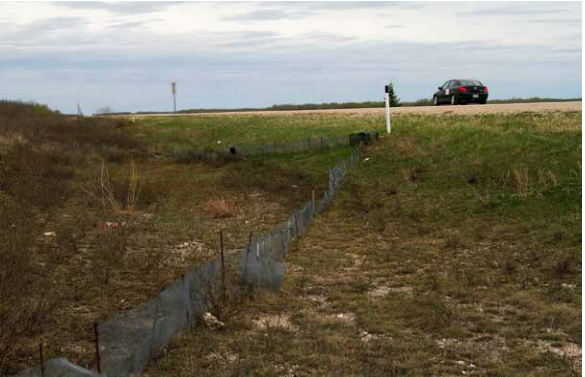
Snake tunnel eli snunnel. Tie katkaisee käärmeiden luontaisen vaellusreitit talvehtimispesiltä kesän saalistuspaikoille. Narcissen kohdalla valmiin tien ali on porattu kymmenkunta tunnelia, joita pitkin käärmeet voivat alittaa tien turvallisesti. Matalat johdinaidat ohjaavat käärmeet kohti tunnelia kuin suppilo.
